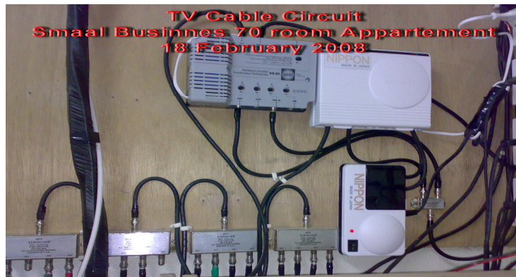
Gambar 6-29. Booster pada TV kabel
