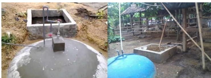
Gambar 2.7 Reaktor biogas dengan sistem digester fixed-dome (Haryanto dkk., 2020)
